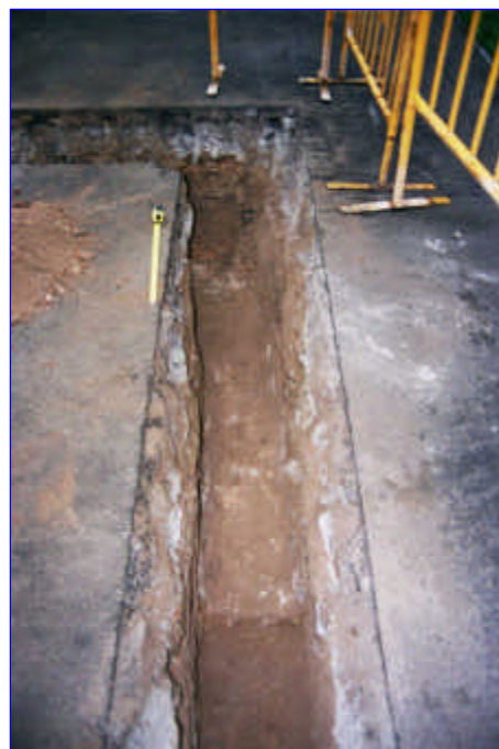
Làmina 17: Foto del tram 2. Muralla de Mar.141/03-2
