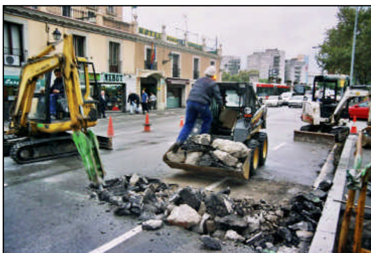
Làmina 4: Obrers treballant al tram 1.
